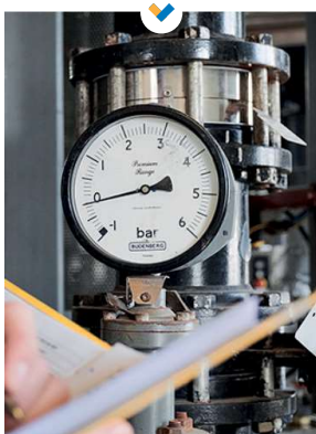
Inert Gas Condition 可进行反应、过滤、干燥、包装工序
